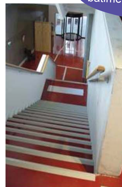
Sécurisation des escaliers
