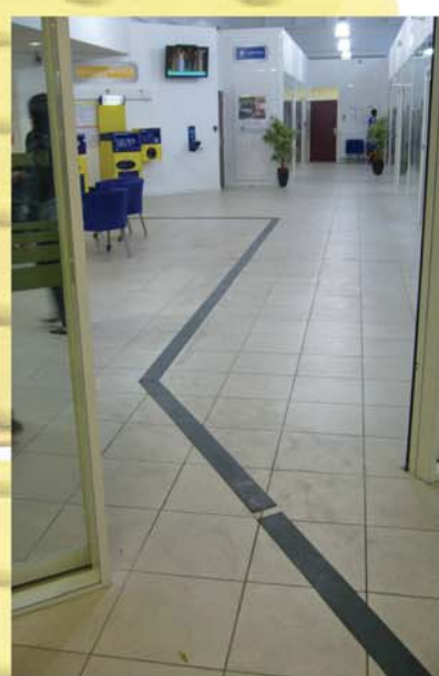
Guidage tactile au sol
